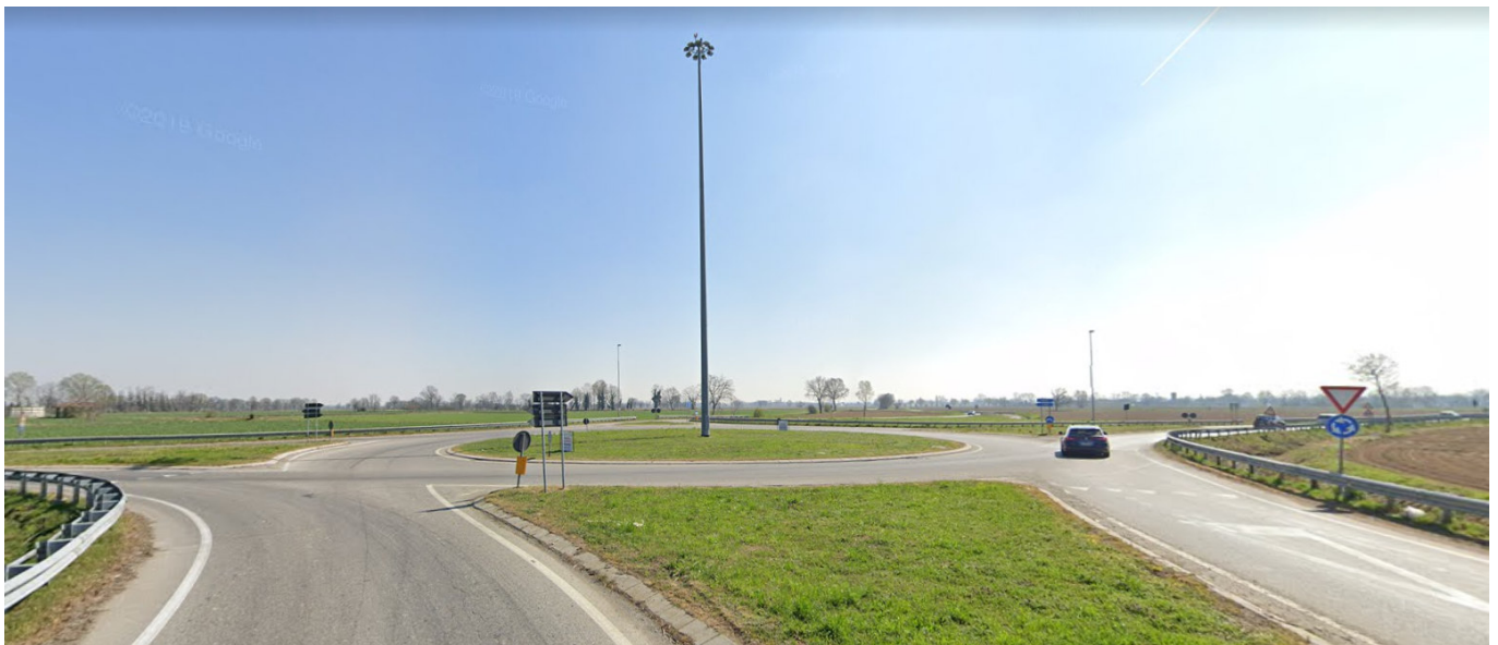
Figura 10 – Intersezione 2: vista dalla via Padre Pio
